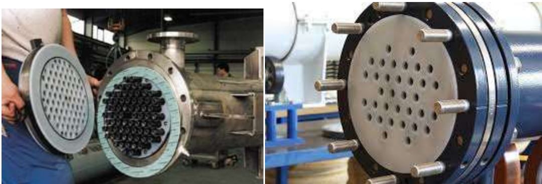
Figure 10 : Plaque tubulaire d'un échangeur de chaleur à tube et calandre
